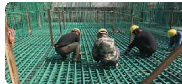
工人在现场编织环氧涂层钢筋
