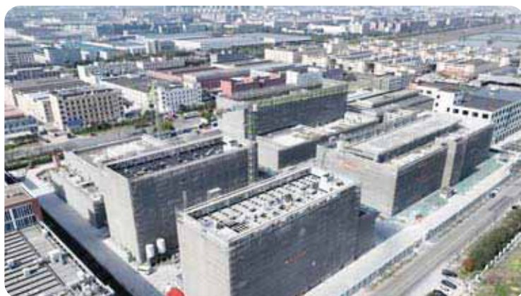
前湾工程化验证与示范园区施工现场
